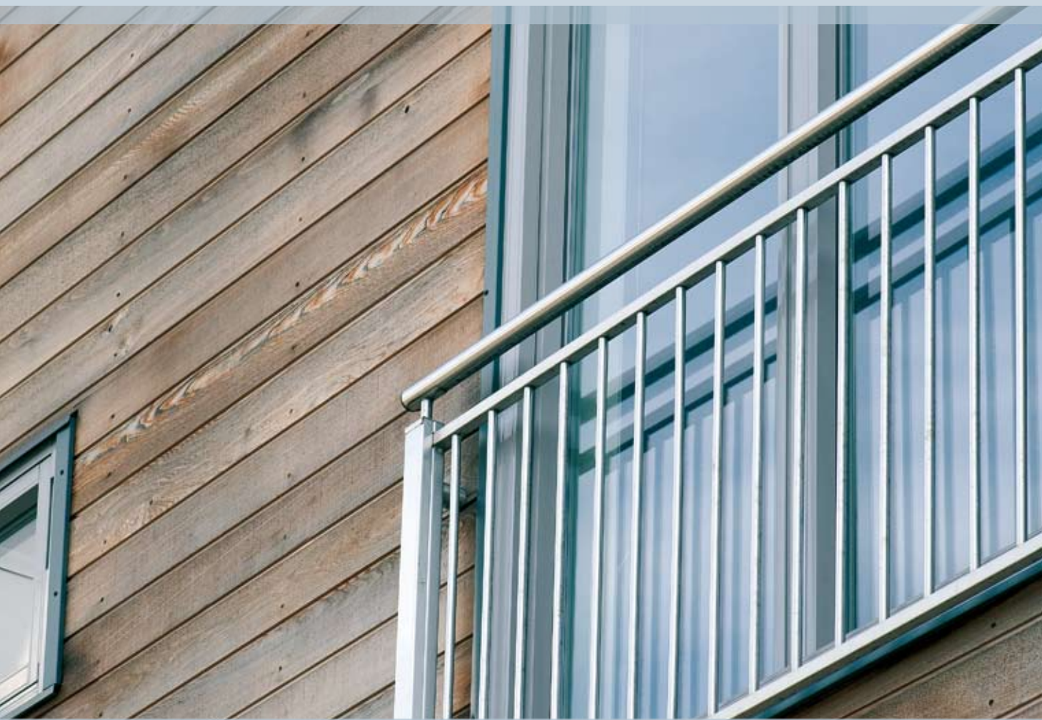
En moderne og stilren balkong
